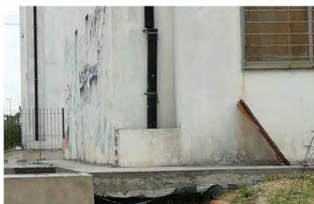
Descalce Inst. Pluvial Platea 08
