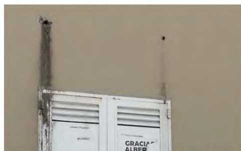
Sec. insuf. y suciedad Inst. Pluvial P02
